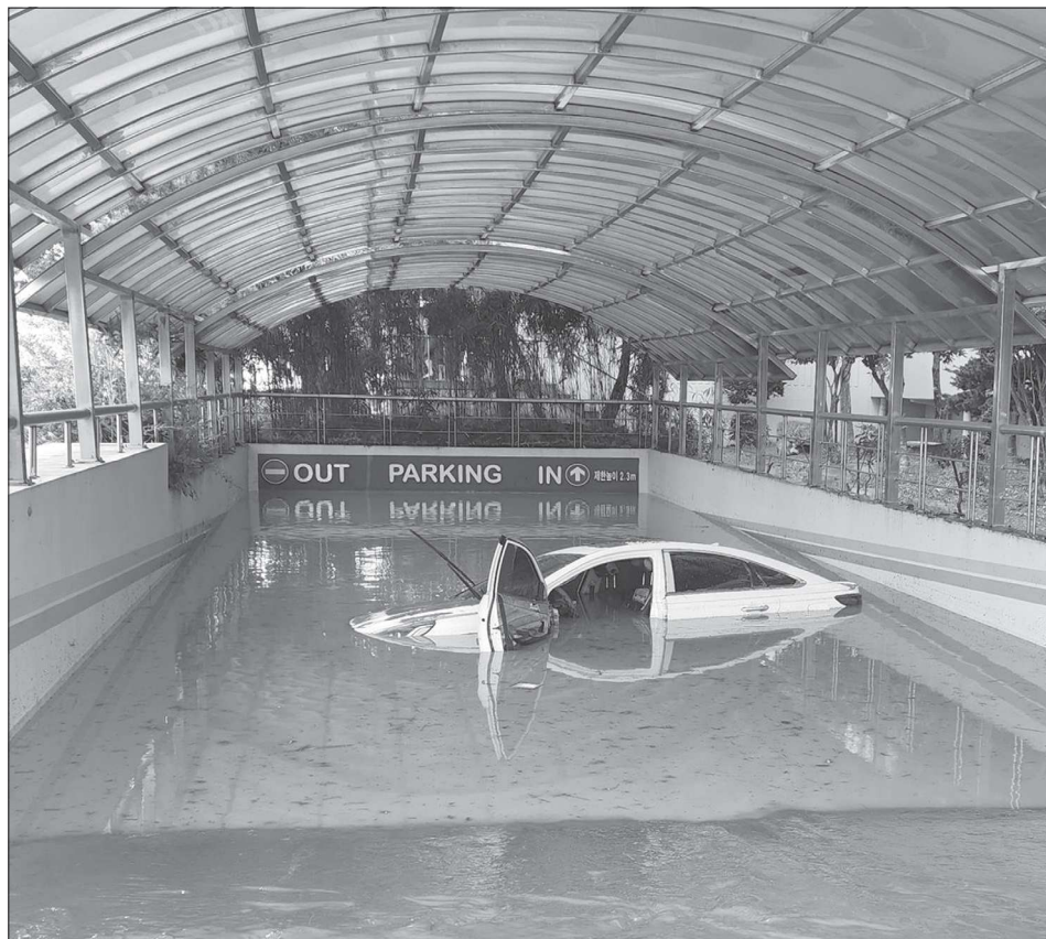
7명의 생명을 앗아간 포항 주차장 침수 사고 지금의 사회 인프라는 기후 위기에 매우 취약하다
