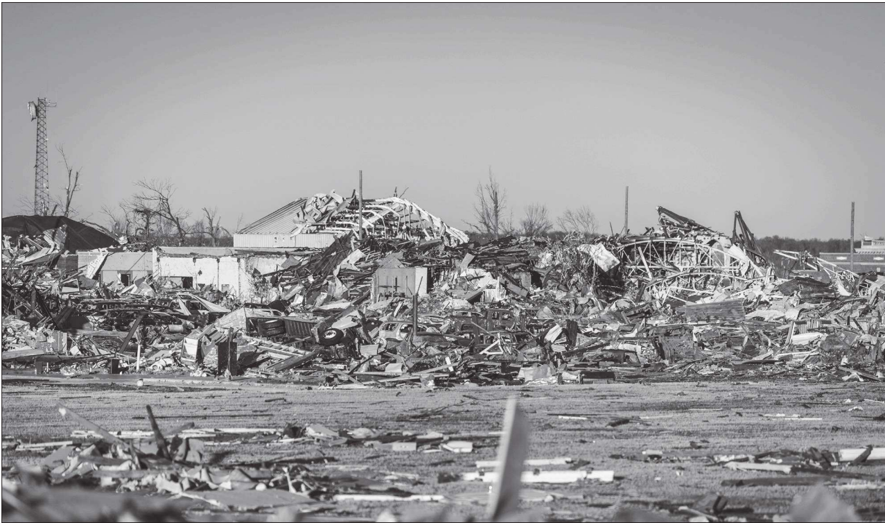
토네이도가 파괴한 미국 캔터키주의 한 도시. 갈수록 심각해지는 기후 재난은 신속하고도 근본적인 체제 변화가 필요함을 보여 준다
